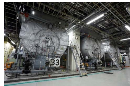
丸の内二重橋ビルプラント内
