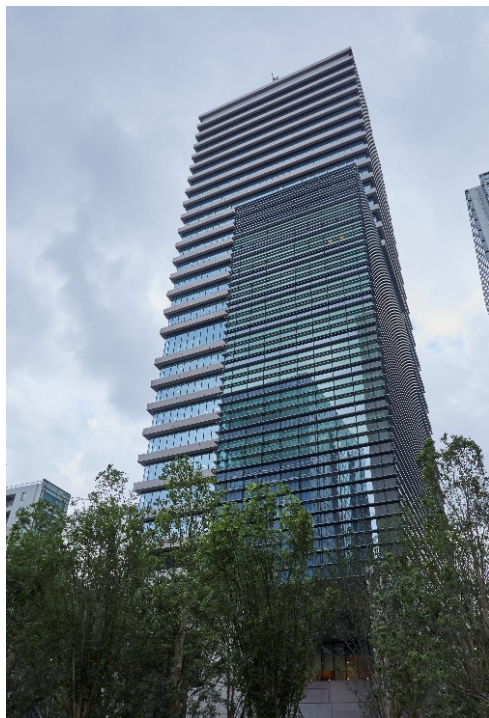
日比谷 FORT TOWER 外観
