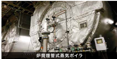
炉筒煙管式蒸気ボイラ
