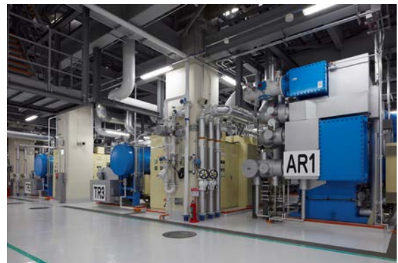
写真② プラント機械室
